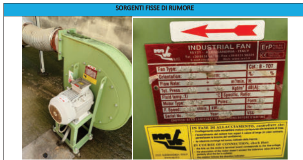
n. 5 aspiratori ossidazione aerobica (in esercizio contemporaneo pari a 2 per volta)
