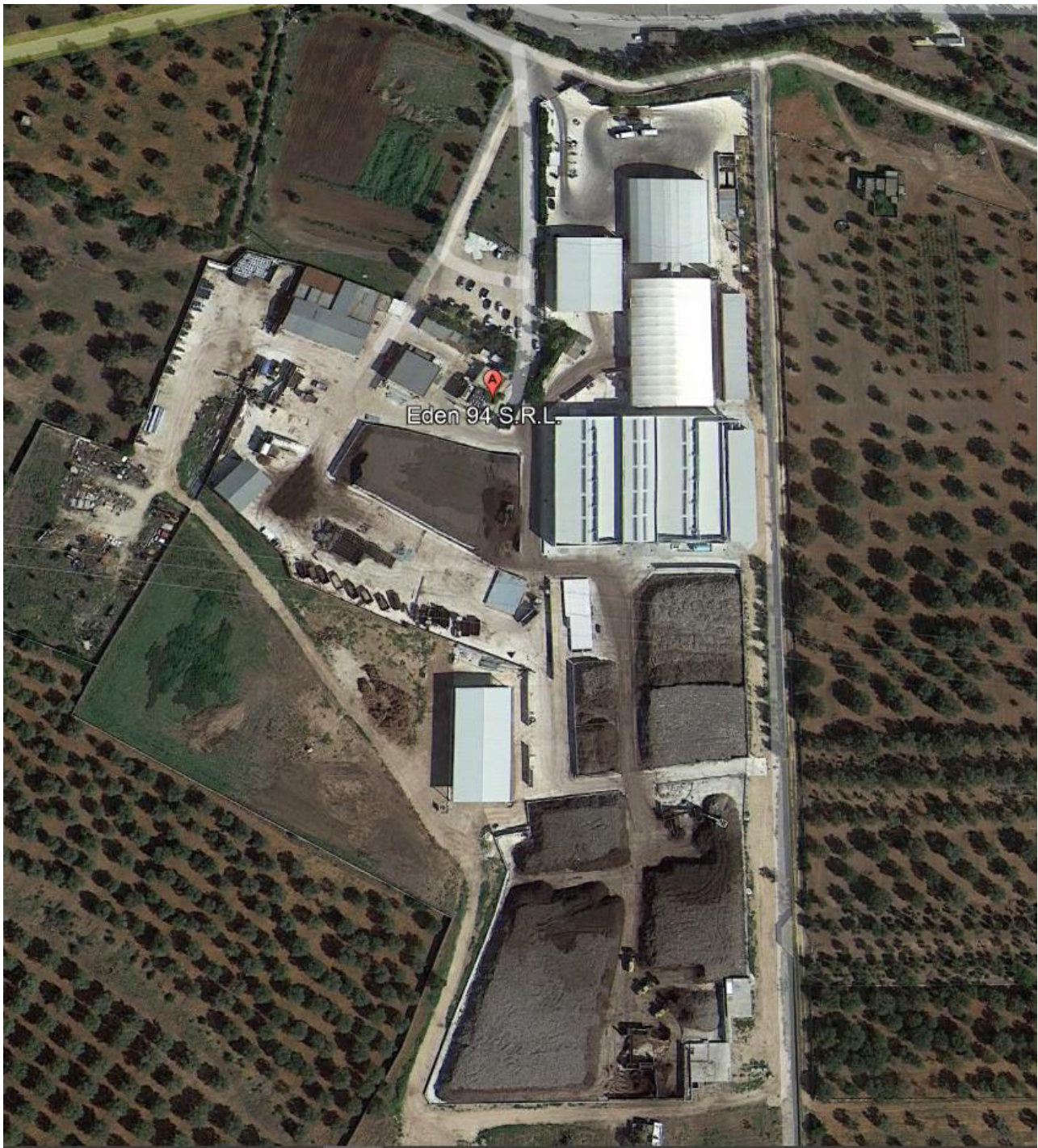
Fig.2 - Vista aerea dell'impianto
