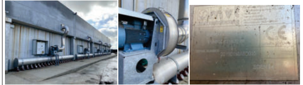
n.5 aspiratori maturazione secondaria (in esercizio contemporaneo pari a 2 per volta)
