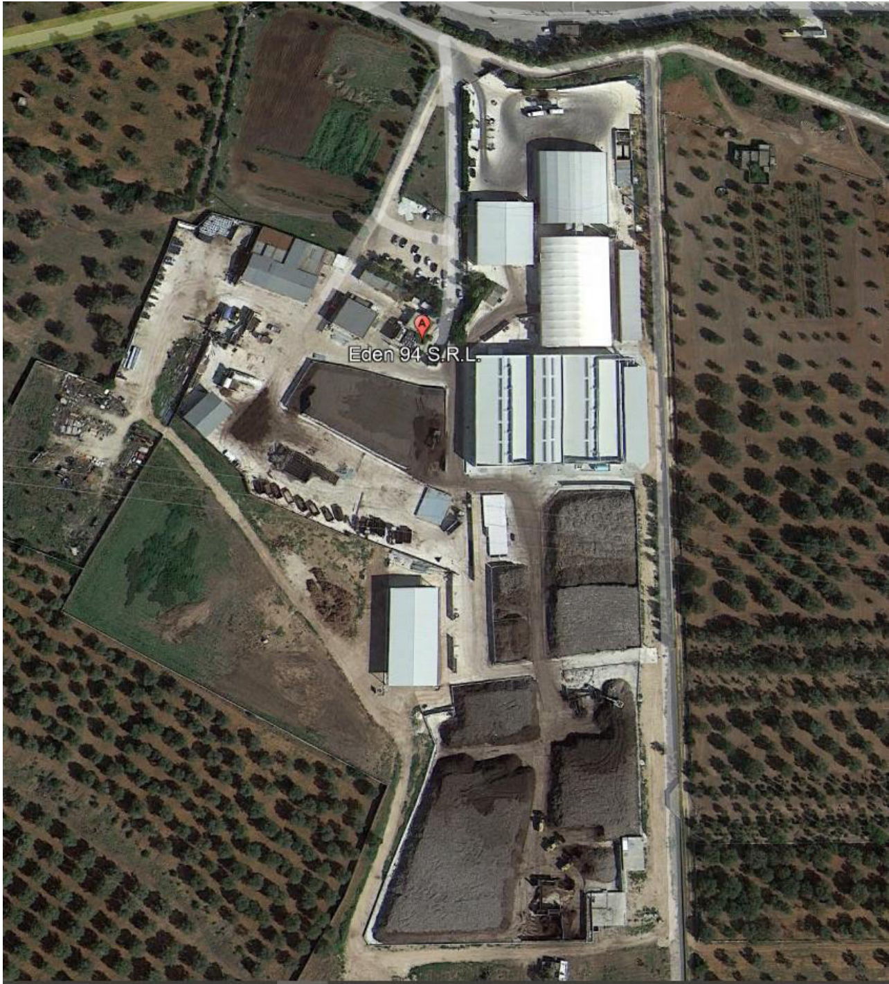
Fig.2 - Vista aerea dell'impianto
