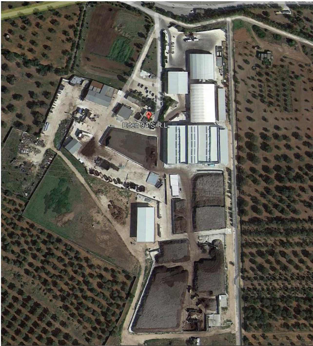
Fig.2 - Vista aerea dell'impianto
