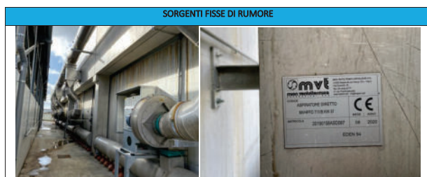
n.5 aspiratori maturazione primaria (in esercizio contemporaneo pari a 2 per volta)
