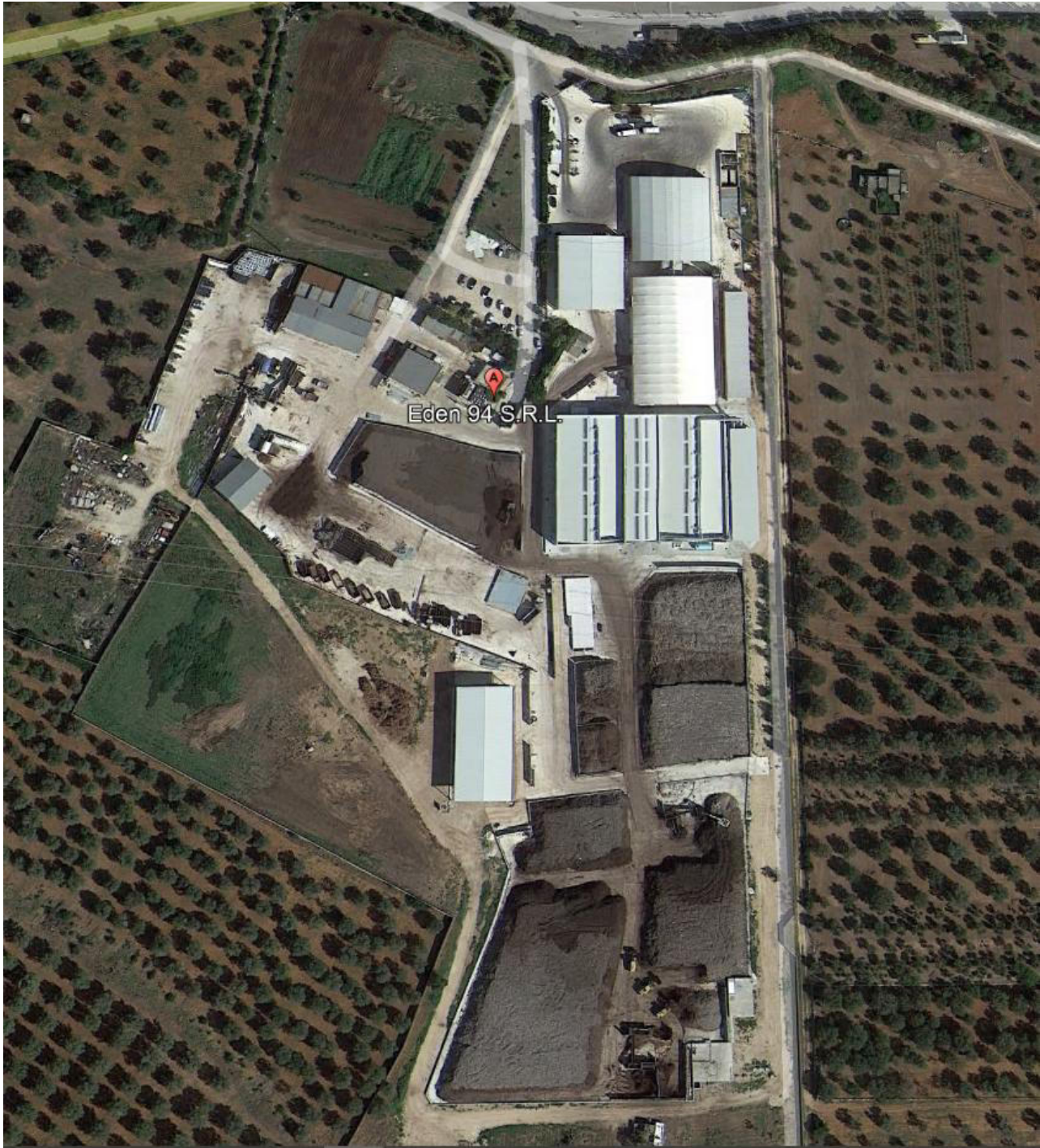
Fig.2 - Vista aerea dell'impianto
