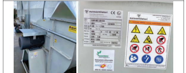
Ventilatore (a servizio del filtro a maniche E3 – Reparto vagliatura Ø10-Ø28)
